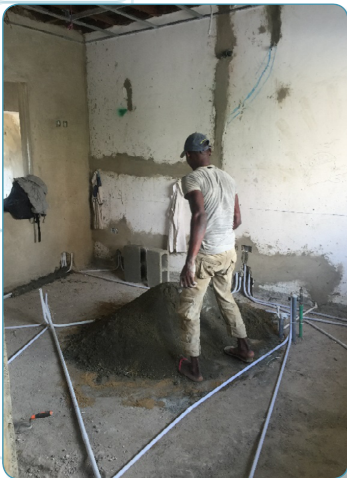
Pré-installation - Mise en place de la tuyauterie et des cables électriques
