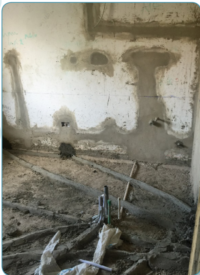
Pré-installation - Mise en place de la tuyauterie et des cables électriques
